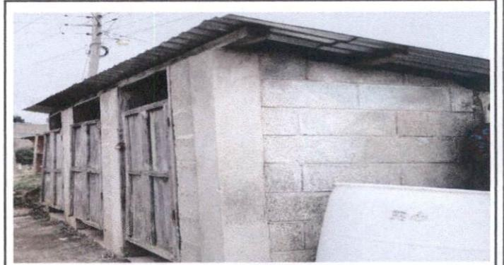
Foto 4: Puertas de metal en baños y sustrucción de lámina, por lámina troquelada calibre 26
